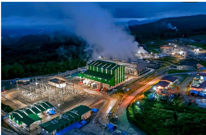
Gambar 1. PLTP Muara Laboh, Sumatera Barat
